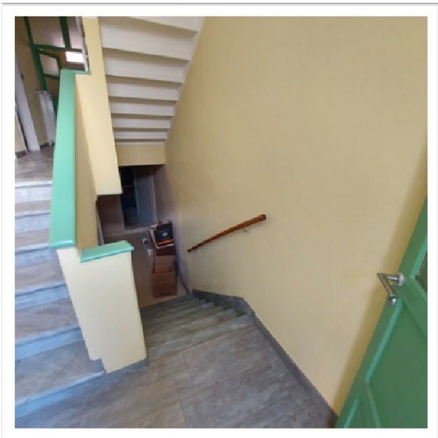
Foto 19 – Scala al Piano Seminterrato
