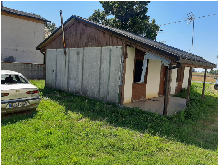
Esterno: vista del fabbricato
