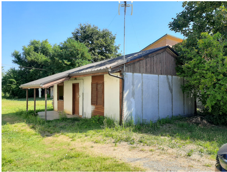
Esterno: vista del fabbricato
