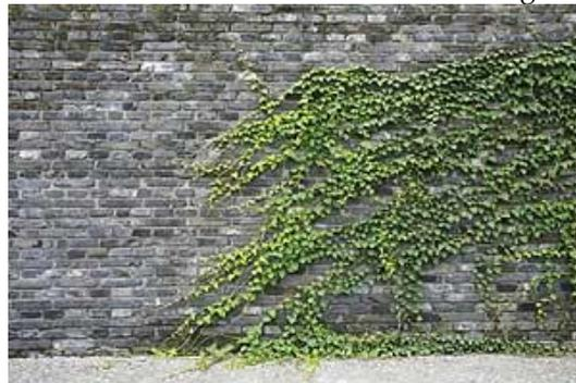
*Fig.1 Esempio indicativo di parete verde in aderenza all'involucro senza struttura di sostegno (rampicanti autosostenuti)*
