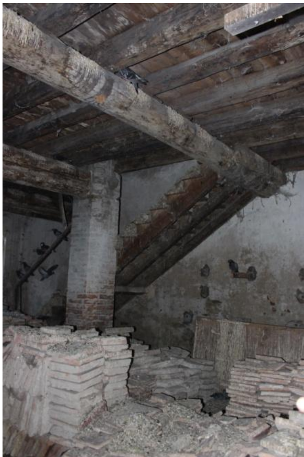
Immagine 9 e 10 Vano PTs2 con scala in legno di collegamento del piano terra con i locali del piano primo. Muro con arco di ripartizione nel muro storico dell'ala EST del Palazzo Ducale
