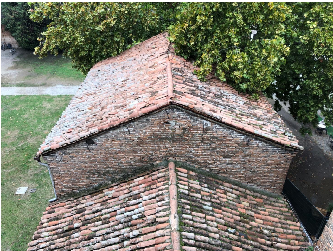
Immagine 8 Vista della copertura dall'alto
