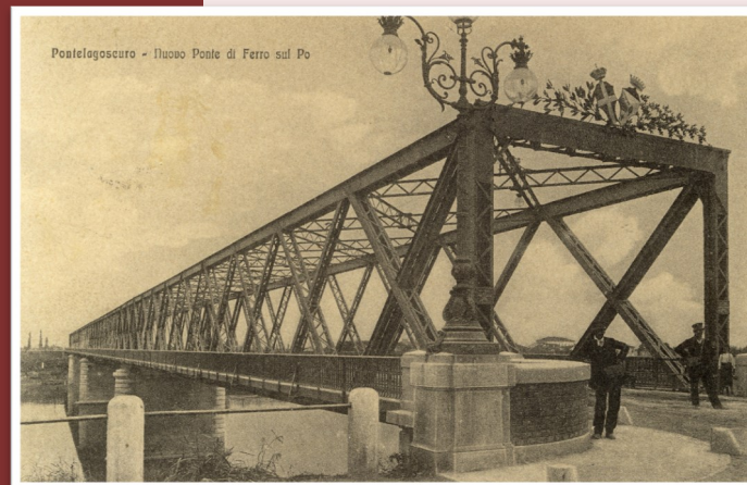
Pontelagoscuro. Il ponte stradale in ferro sul Po, inaugurato l'11 aprile 1912. (WF)
